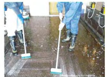
防滑処理施工中
