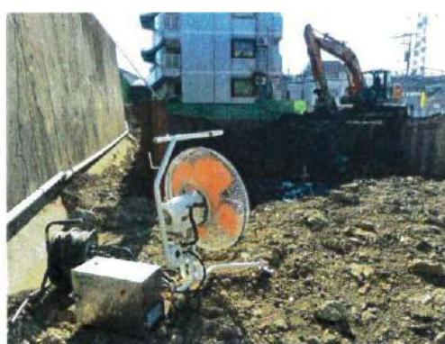
廃棄物が混入された土壌の掘削工事中の現場。移動可能な機器を適宜配置し、空気中に消臭剤を発散させて工事現場のにおいを抑えます。
